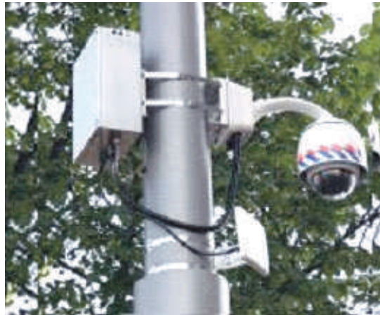
Şek.6.6: Gözetleme kameranın yerleşimi
